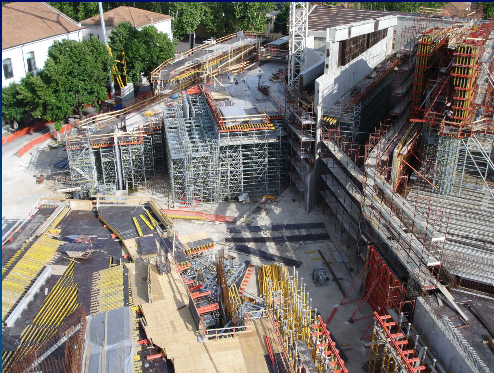
BANCHINAGGI – VISTE GENERALI CANTIERE
