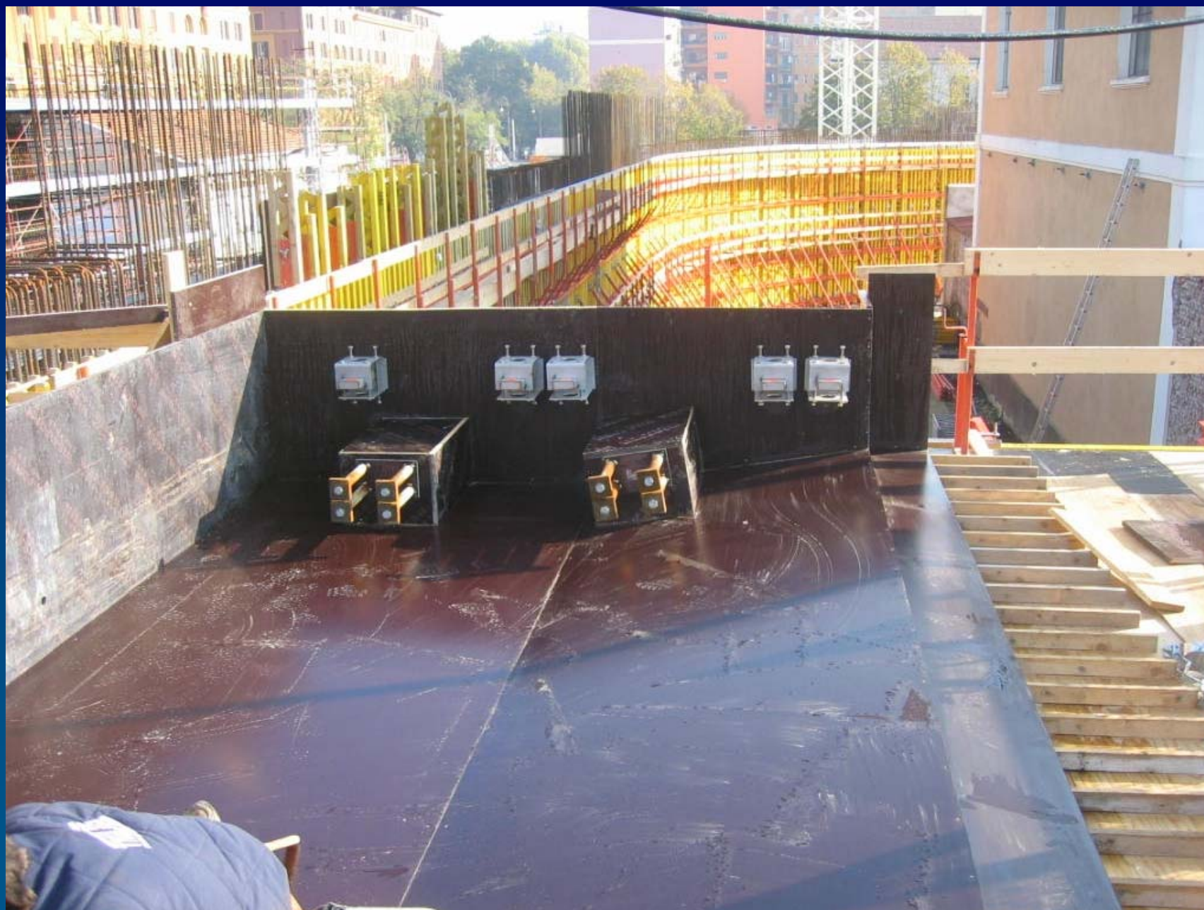
INSTALLAZIONE SHOCK TRANSMITTERS E CRET NELLA BALCONATA
