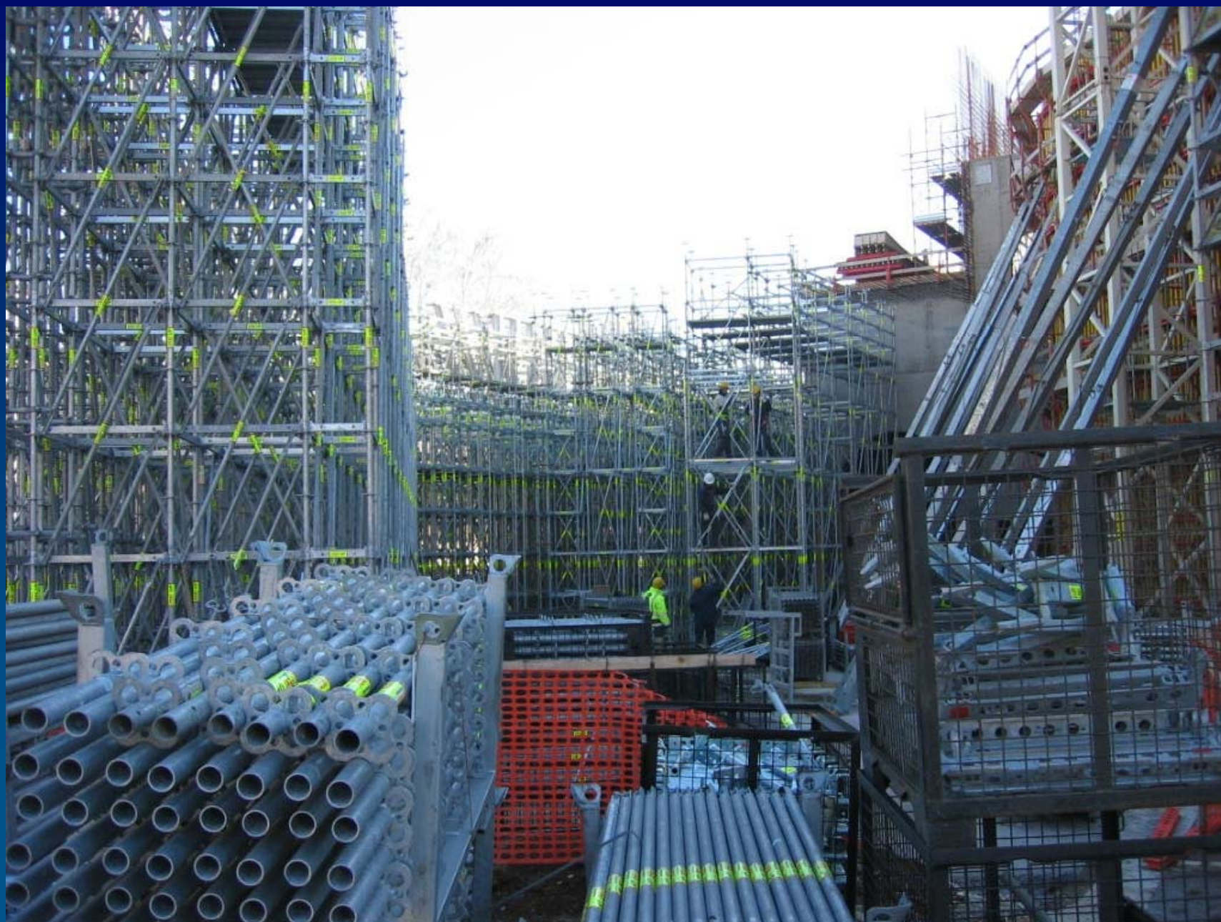
SUITE III – BANCHINAGGI SOLAI
