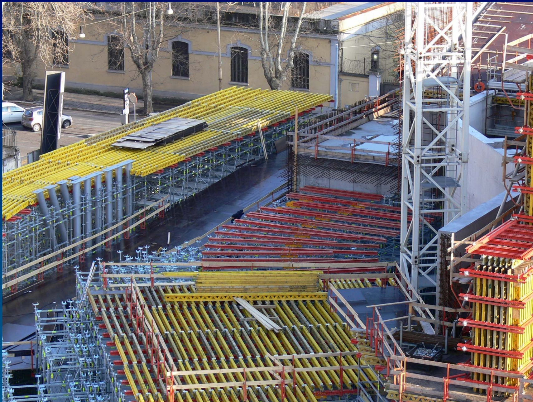
SVITE III- BANCHINAGGIO SOLAIO
