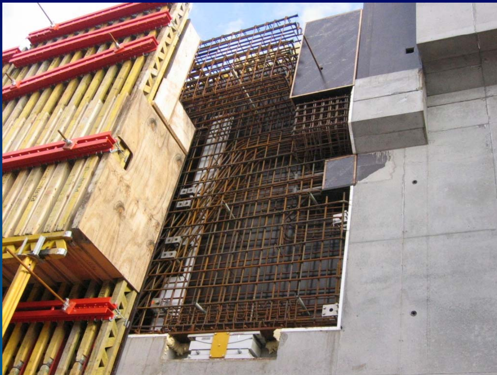
ARMATURA SUPPLEMENTARE APPARECCHI DI APPOGGIO
