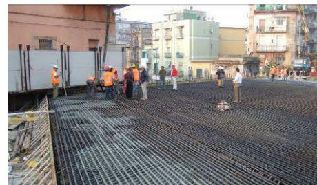
Figura 7 – Armature del cordolo e dell'impalcato, con particolare dei ferri
