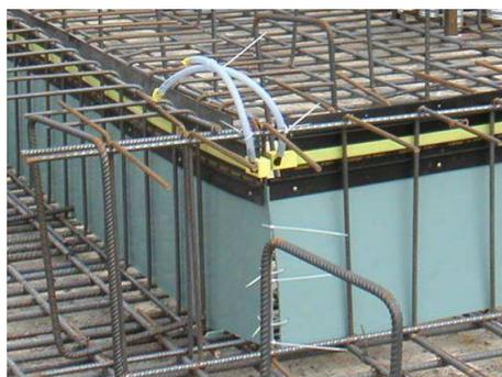
Figura 6. Elemento di prefessurazione
