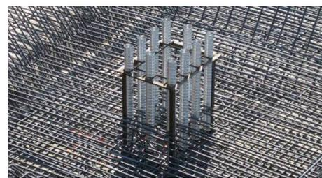
Figura 16. Inserti di collegamento nella platea
