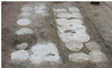
Figura 4. Estradosso colonne vano scala
