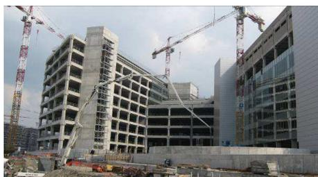
Figura 14. Strutture prefabbricate edifici 1 e 2
