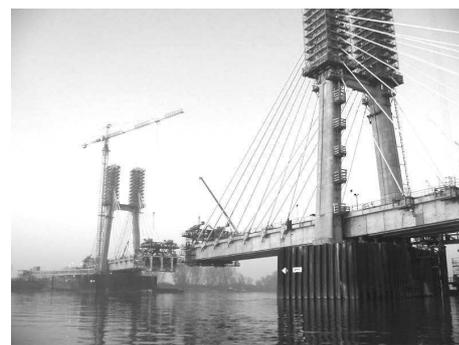
Figura 10 – Costruzione dell'impalcato strallato
