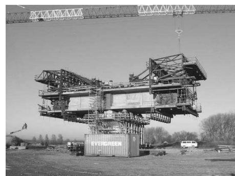
Figura 9 – Costruzione a sbalzo dell'impalcato
