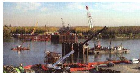
Figura 7 – Costruzione delle fondazioni in alveo
