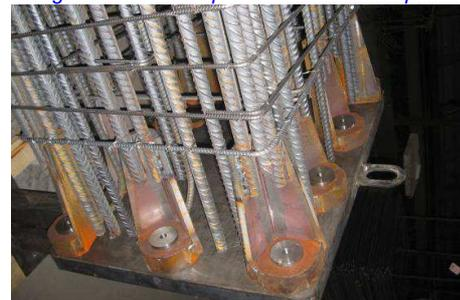
L'utilizzo di dime anche nel posizionamento degli inserti all'interno del pilastro ha evitato ogni problema legato al corretto posizionamento dei tirafondi. Per il fatto che i pilastri sono stati realizzati con  $R_{ck} = 50$  MPa e le fondazioni con un  $R_{ck} = 35$  MPa si è realizzato un collare alla base del pilastro con malte cementizie ad alta resistenza per trasmettere il carico su una superficie di distribuzione maggiore.
