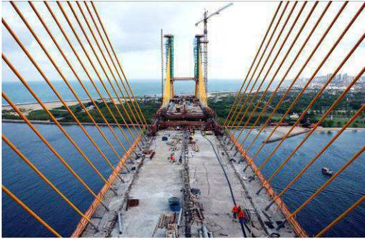
*Prosegue la costruzione a sbalzo, e parallelamente l'esecuzione delle barriere stradali e delle finiture*
