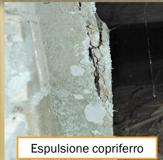
Corrosione armature
