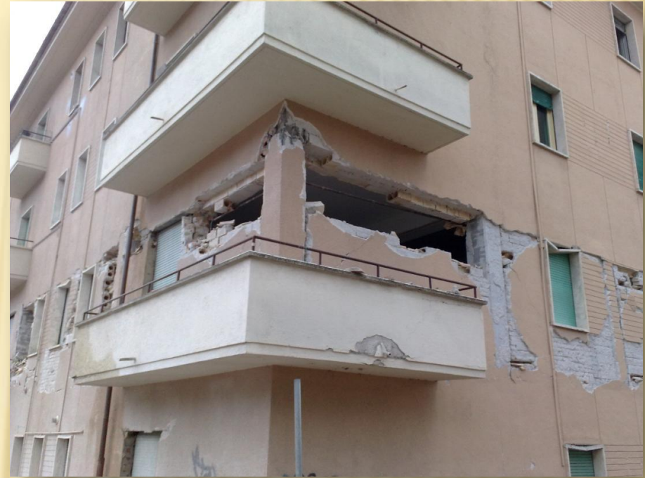
Rottura locale: Trave forte – pil. debole
