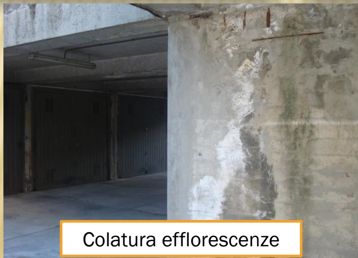
Infiltrazioni d'acqua
